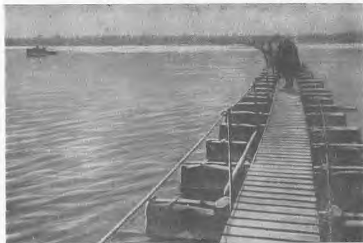
Понтонный мост через реку Волгу в районе Денежного острова и хутора Скудры.
