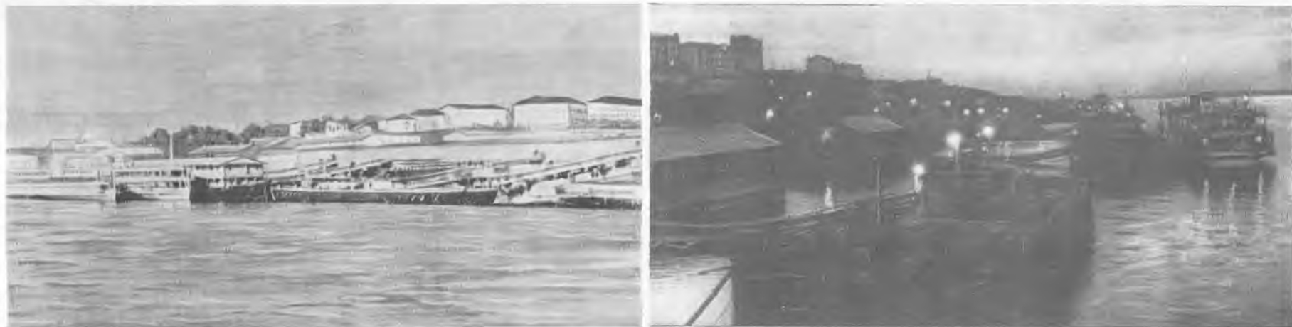
Общий вид причалов Центральной переправы у правого берега от реки Пионерки до Киевского взвоза.
